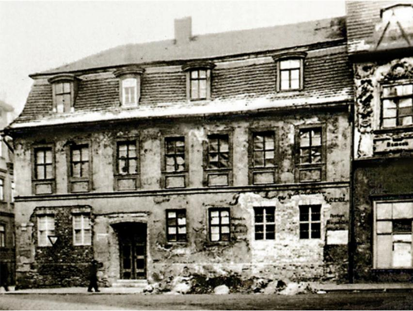
*Das Händel-Haus zu Beginn der Bauarbeiten im Winter 1946. Hier war das Schaufenster bereits zugemauert und durch rechteckige Fenster ersetzt*
